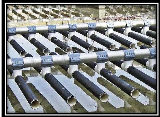
دیفیوزر لوله ای OXYaero<sup>TM</sup> ساخت شرکت مهندسی فراز تصفیه دارای عملکرد عالی برای انتقال اکسیژن به حوضچه های هوادهی در سیستم های تصفیه فاضلاب و پرورش ماهی می باشد .
