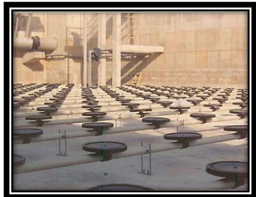
دیفیوزر دیسکی **OXYaero™** ساخت شرکت مهندسی فراز تصفیه به منظور هوادهی در حوضچه های تصفیه فاضلاب و پرورش ماهی کاربرد زیادی داشته و دارای ماکریم ظرفیت هوادهی بصورت یکنواخت بوده و با کمترین فشار عملیاتی کار می کند.
